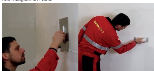
Abbildung 7 Spachteln mit Firestop Finish Spachtelmasse; Schleifen der Firestop Finish Spachtelmasse (wenn notwendig)
