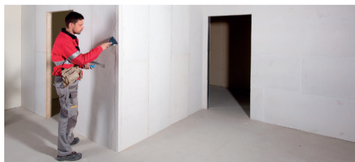
Abbildung 6 Kantenschutz spachteln
