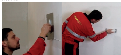
Obrázek 7 Vrchní tmelení; broušení tmelem Firestop finish (pokud je to nutné)
