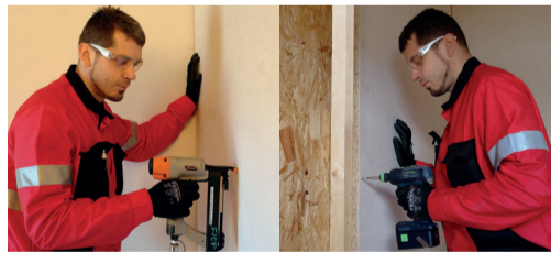
Abbildung 3 Klammern von Platten oder Befestigung mit Hilfe von Holzschrauben
