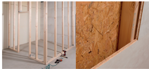
Zdjęcie 1 Konstrukcja ramowa, montaż na drewnianą konstrukcję ramową
