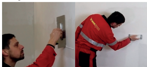
Zdjęcie 7 Ostateczne szpachlowanie, szlifowanie masy szpachlowej Firestop Finish (jeżeli jest to konieczne)
