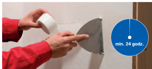
Zdjęcie 5 Taśma wzmacniająca - następuje przerwa technologiczna min. 24 godz.
