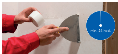
Obrázek 5 Výztužná páska - následuje min. 24 hodinová technologická přestávka
