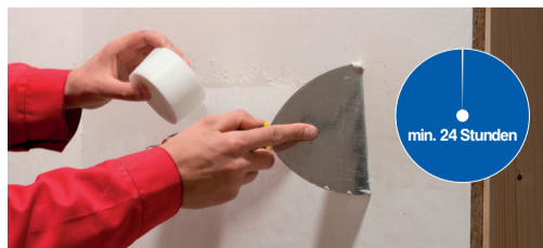
Abbildung 5 Versteifungsband - es folgt min. 24-Stunden-technologischer Pause
