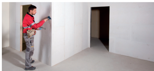
Zdjęcie 6 Wykończenie rogu konstrukcji ściany
