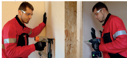
Zdjęcie 3 Mocowanie płyt zszywkami lub wkrętami
