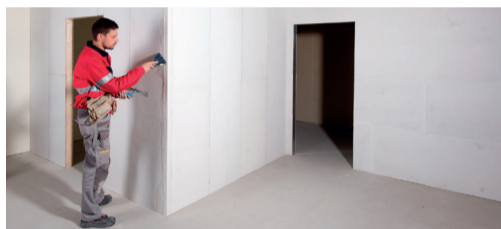
Obrázek 6 Tmelení rohu konstrukce stěny
