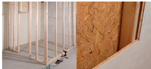
Obrázek 1 Rámová konstrukce; montáž na dřevěnou rámovou konstrukci
